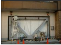
鉄骨ブレース取付
