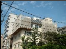
耐震工事外観
